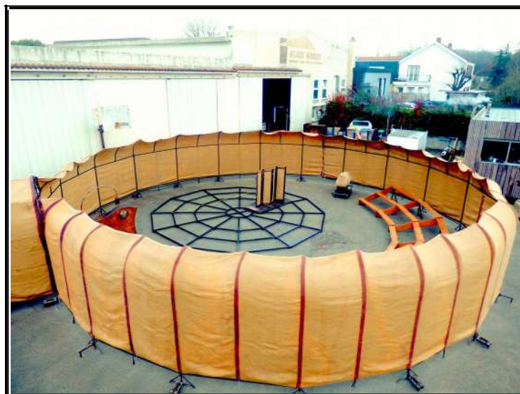
Palc et scénographie en cours de construction
